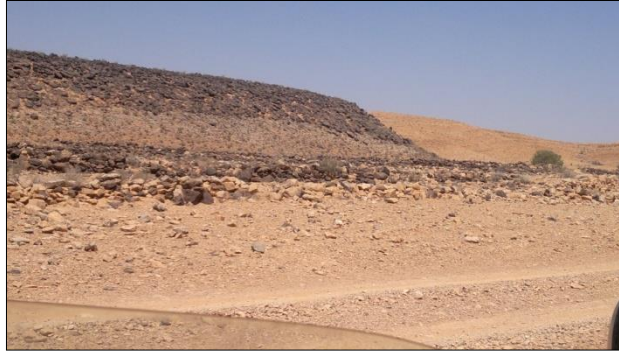
شكل (9) أعمال مقاومة الانجراف بالأراضي غير الصالحة للزراعة. (المصدر: إعداد الباحثين).
